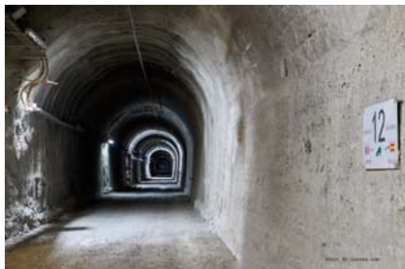
Fig. 1.2: El Túnel Ferroviario
