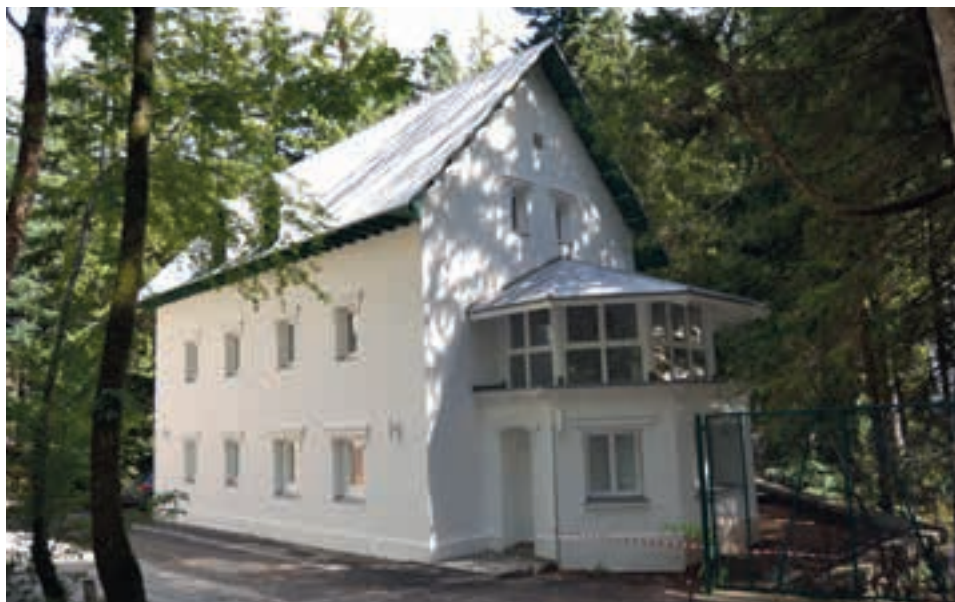
Fig. 2.7: The refurbished "Casa de los Abetos"
