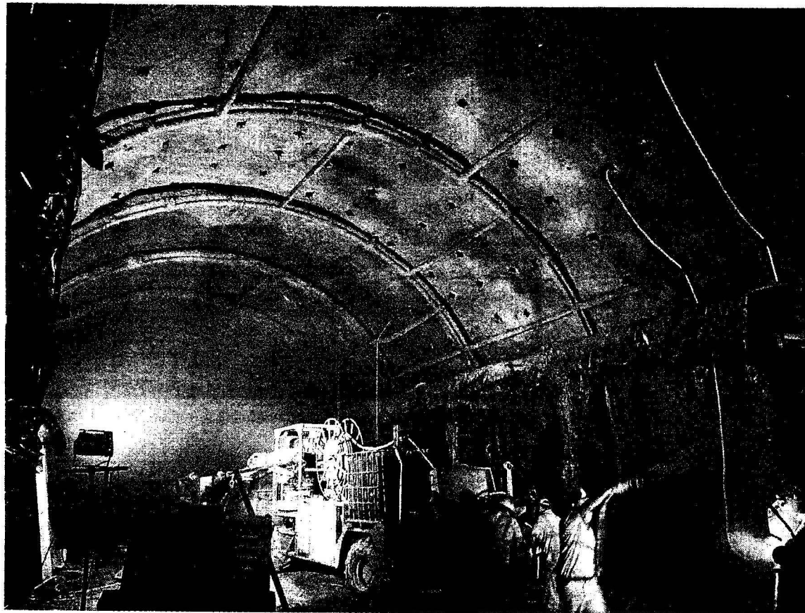
Trabajos de proyectado de hormigón en la galería peatonal de acceso a la sala experimental. HERALDO
