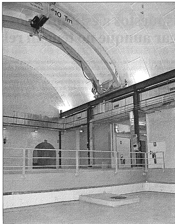
Sala central del Laboratorio Subterráneo de Canfranc tras las obras de refuerzo llevadas a cabo en estos tres últimos años
