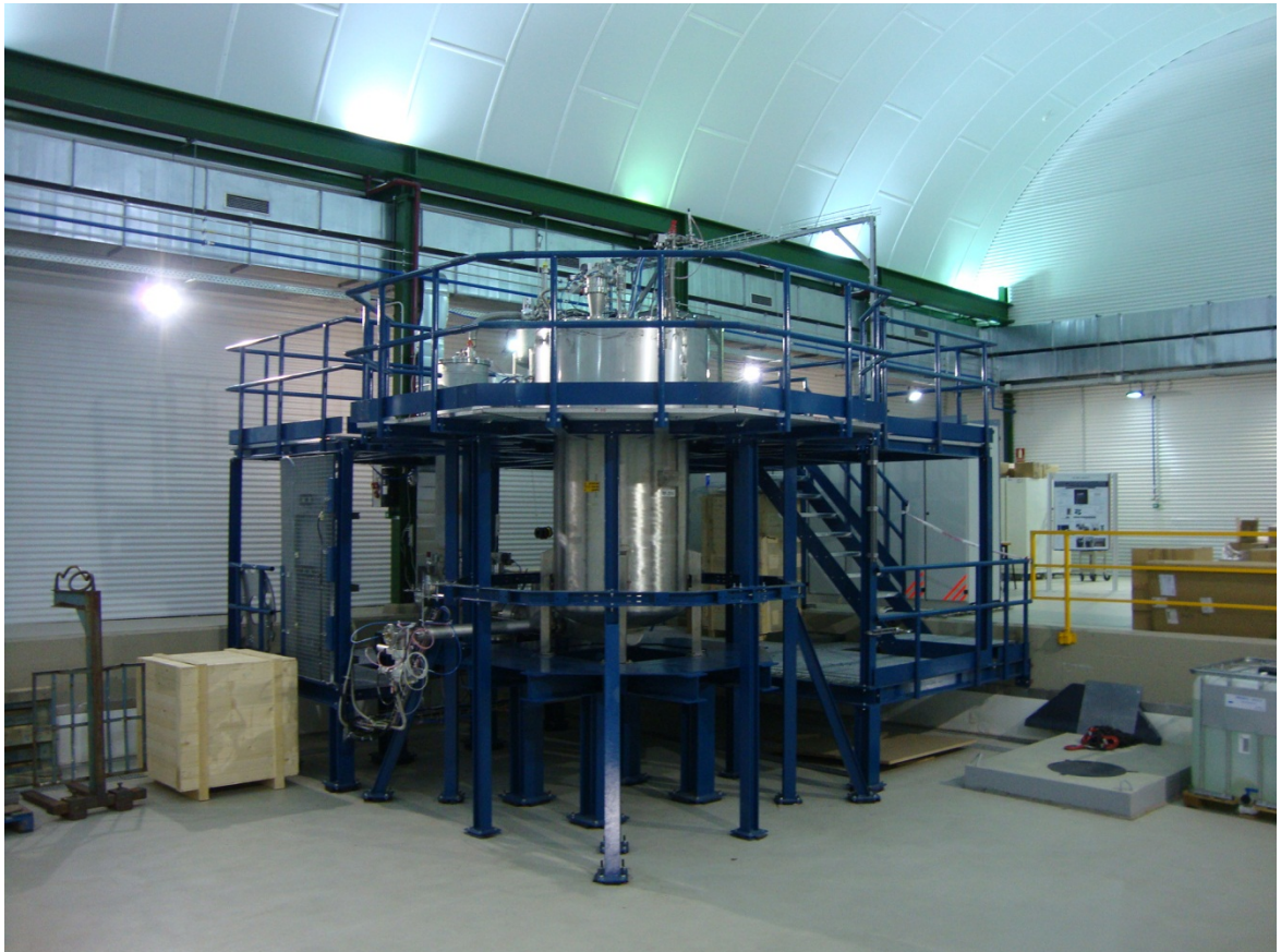
Instalación de la estructura, Marzo 2012
