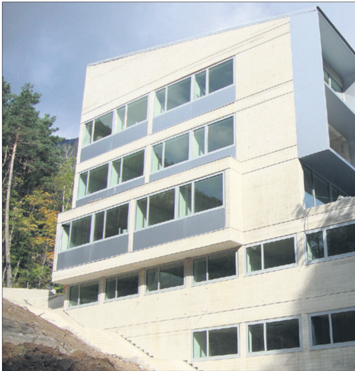
Edificio del Laboratorio de Canfranc. R.G.
